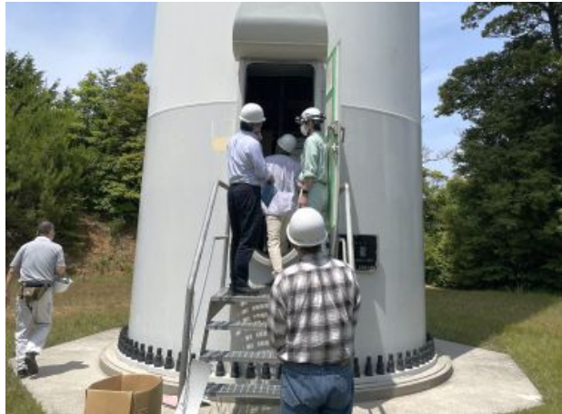
8号風車タワー入口部
