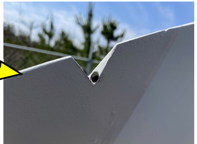
ブレード先端部の水抜き穴
