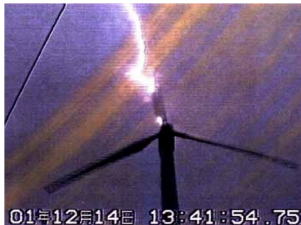
ブレードへの雷撃例（NEDO 資料）
