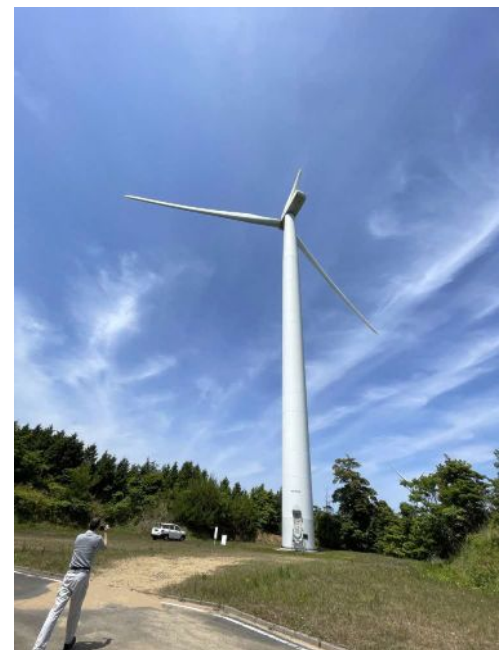
江津高野山風力発電所（8号機）
