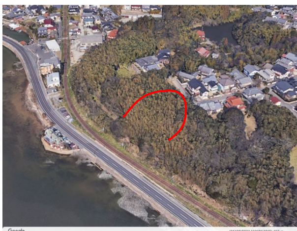
宍道湖に面する地すべり危険箇所
