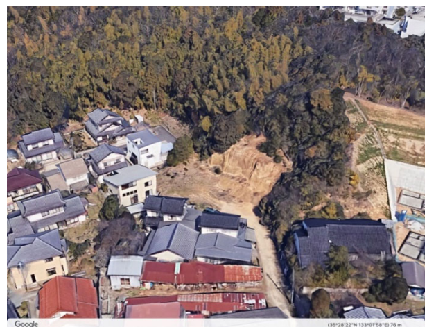
団地周りにある小規模な急傾斜危険箇所
