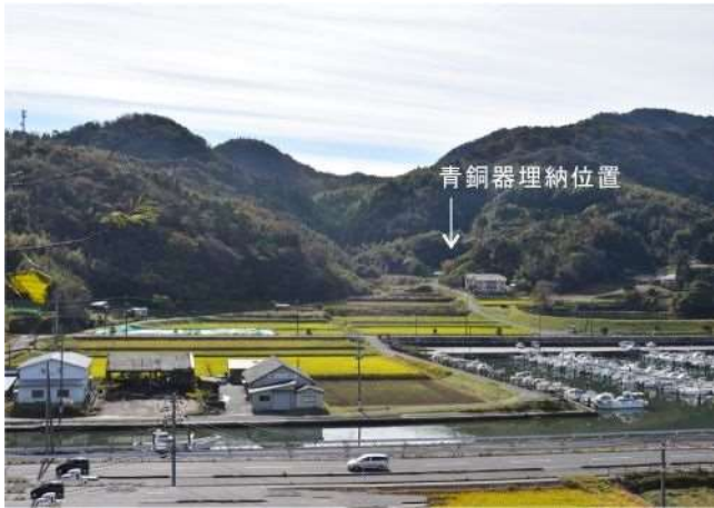
写真-1 志谷奥全景
