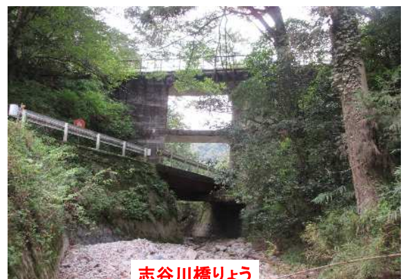
旧三江線-目の字形ラーメン橋（1連3層）
