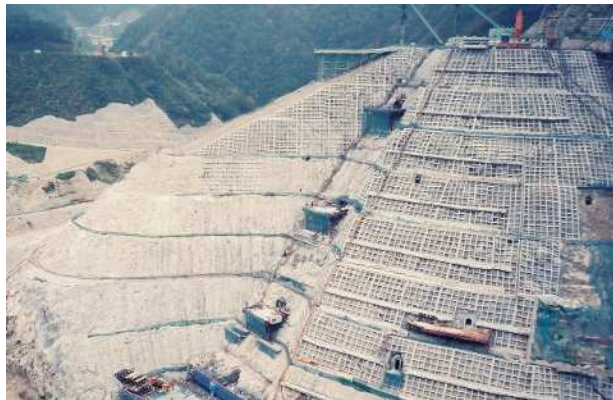
写真 4.1 建設中の法面
