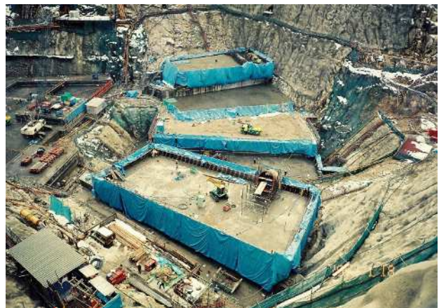
写真 4.3 堤体打設状況
