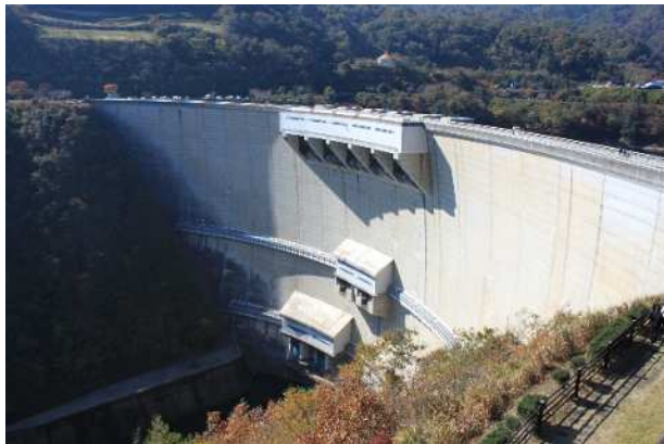
写真 2.1 左岸下流側より
