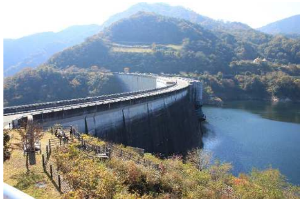
写真 2.2 左岸上流側より
