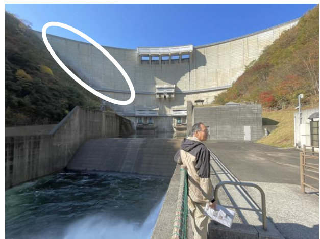
直下流から見上げた温井ダム
