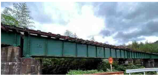
写真1 川平橋りょう（5連単純鉸桁橋）
