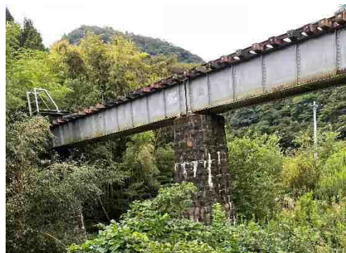
写真 7 瀬尻川橋りょう 石積み橋脚
