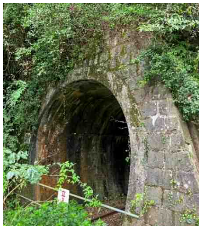
写真 28 川戸トンネル
