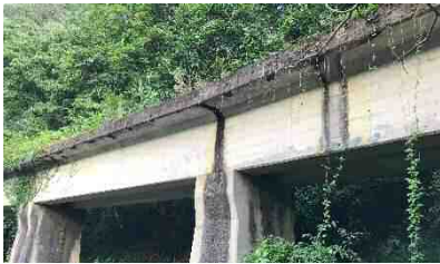
写真13 第1権現谷橋りょう 支間長9.8m
