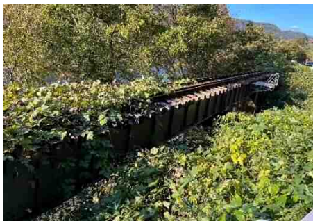
写真11 檜山陸橋 3連単純板桁橋
