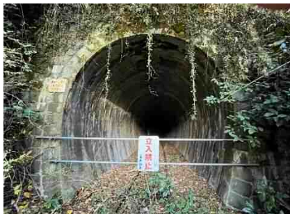
写真 26 近原トンネル
