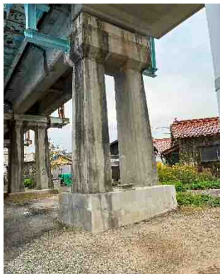
写真15 馬洗川橋りょう (ラーメン式橋脚区間)
