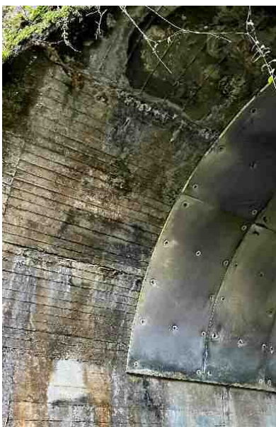
写真 25 第1江口トンネル アーチ部
