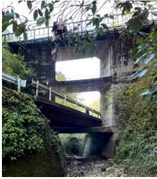
写真9 志谷川橋りょう
