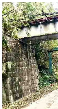
写真 8 八戸川橋りょう 石積み橋台
