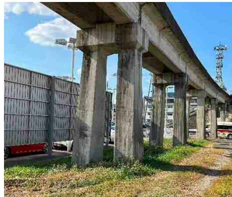
写真16 十日町架道橋
