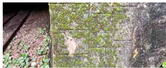
写真 24 コンクリートブロック覆工厚 花河原トンネル 側壁部
