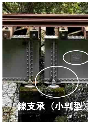
写真12 檜山陸橋 線支承 (小判型) と 橋銘板
