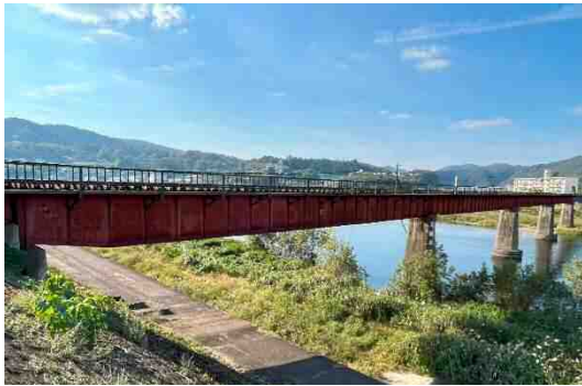
写真17 馬洗川橋りょう 船底形プレートガーダ橋
