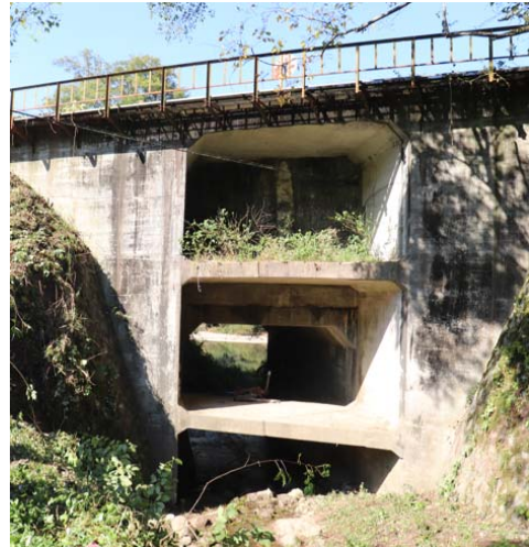
写真-2 日向川橋りょう
