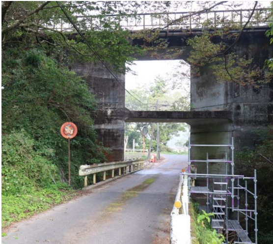
写真-1 志谷川橋りょう
