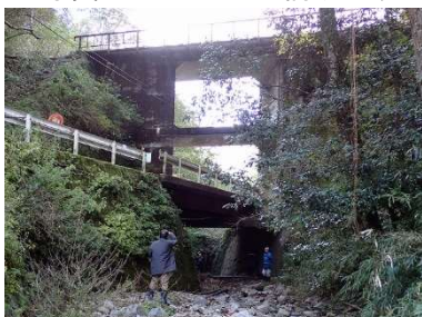
写真 3.3.5 志谷川橋りょう
