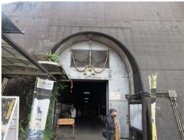
写真 3.1.5 葛原トンネル坑口
