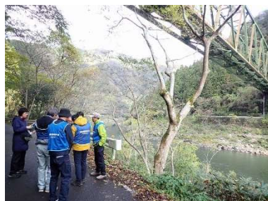
写真 3.3.4 第二江川橋りょう
