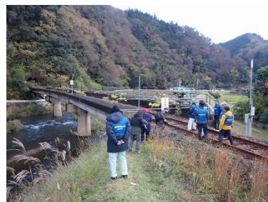
写真 3.3.2 出羽川橋りょう
