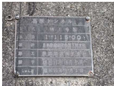
写真 3.1.6 トンネル銘板
