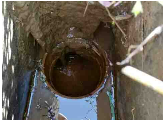
切欠きパイプを取り除いた状況
