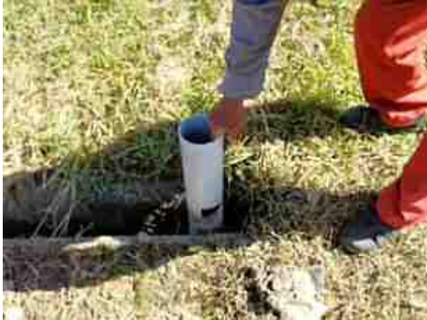
「排水溝よけじ」切欠きパイプ設置状況
