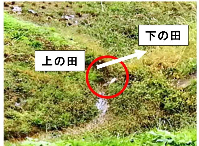
「土水路よけじ」流末パイプ設置状況
