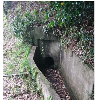
2号水路隧道終点
