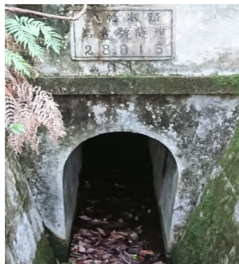
1号水路隧道起点
