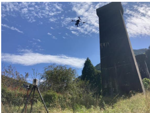
写真7 UAV飛行状況とRTC360 による計測状況
