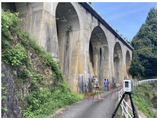
写真 3 地上型 3D レーザースキャナ (RTC360) による計測状況
