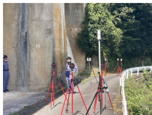
写真 4 GNSS、ターゲット設置状況
