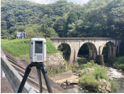
写真5 地上型3Dレーザースキャナ (RTC360)による計測状況
