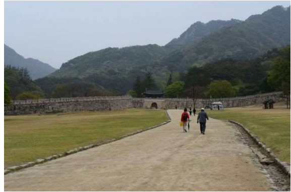
写真-5 鳥嶺関第1関門
