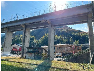
写真6 橋脚 橋脚厚さ 90 cm
