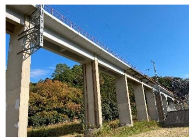
写真3 第2多々良橋 橋脚厚さ 80 cm
