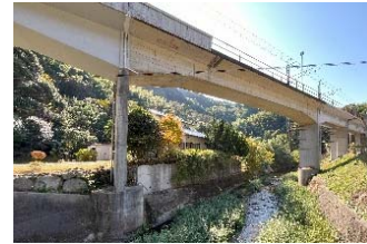
写真5 橋脚 橋脚厚さ 40 cm
