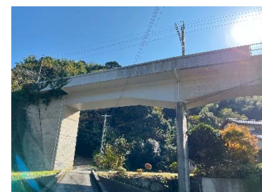
写真9 第4多々良橋 桂川側橋台
