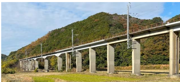
写真2 第2多々良橋梁
