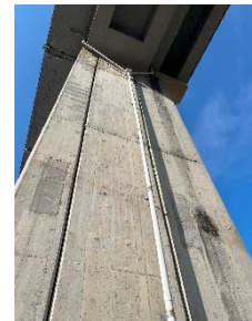
写真8 山手橋梁 ジョイント部
