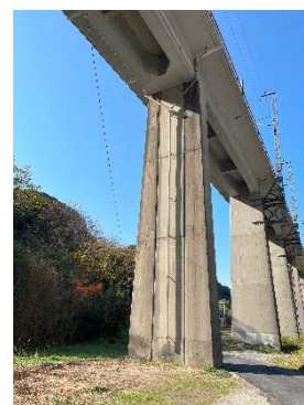
写真10 第3多々良橋梁 ジョイント部
