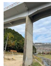
写真4 鳴淵橋 B-B 断面の橋脚 橋脚厚さ 40 cm
