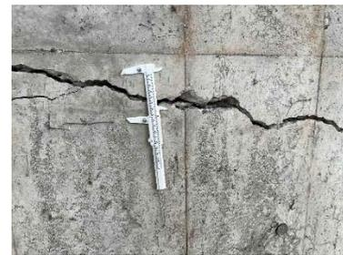
写真-4.5 橋台部貫通ひび割れの状況
