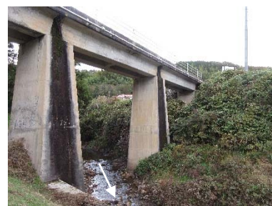
図3. 橋脚位置と河川状況
