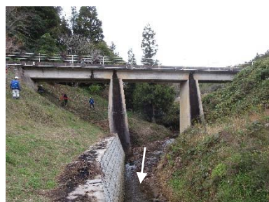
図1. 全景（下流側より）
