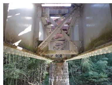
図 17. 上部工（桁下より）
