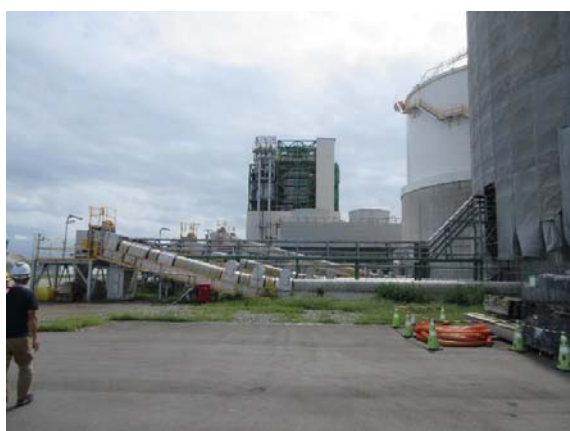
写真 3-5 サイロから燃料を引出し、ベルトコンベアで搬送する。
