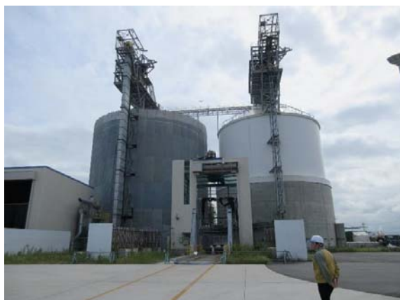
写真 3-3 燃料貯留槽（サイロ）A2.A1
