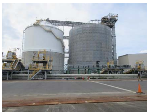
写真 3-6 左記コンベアから 90 度左に、二次コンベアで搬送する。
