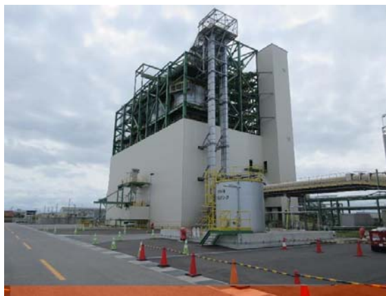
写真 3-8 二次コンベアから垂直に2本のバケット コンベアで燃料が運ばれ、ボイラーに投入される。
