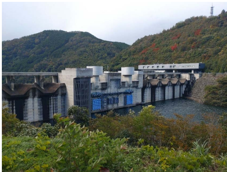
写真 4 ラビリンス型非常用洪水吐
