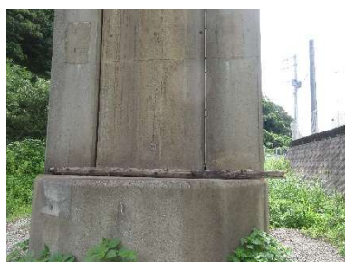
写真 3.3.2 フーチング天端まで 延びるスリット
