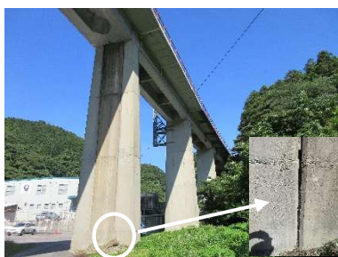
写真 3.3.1 第3多々良橋りょう スリットは開口
