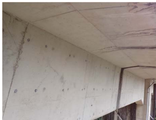
図-9 旧三江線 宇都井高架橋ラーメン剛結部曲げひび割れ
