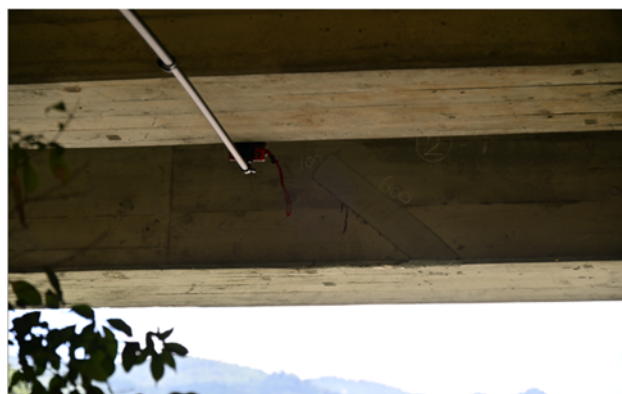
図-8 JR 九州篠栗線 山手高架橋ラーメン剛結部曲げひび割れ
