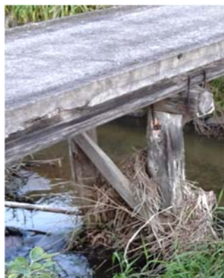
写真-22. 丸太材+コンクリート床版（非合成）
