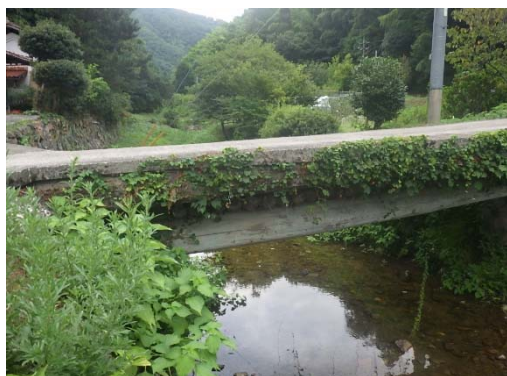
写真-22. 丸太材+コンクリート床版（非合成）
