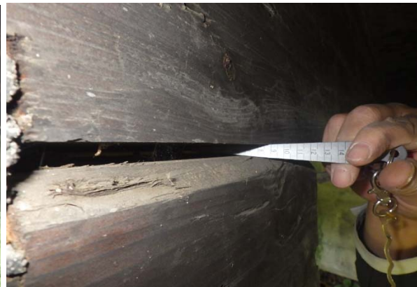
写真-9. 主桁・添え桁の肌離れ
