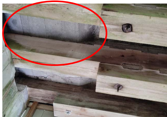
写真－15. 床版端部の打ち降ろし
