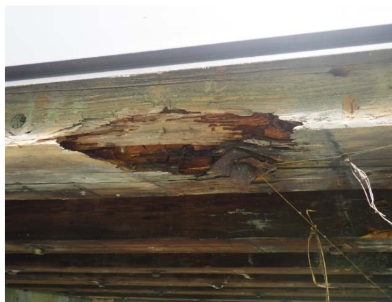
写真-10. 主桁の損傷
