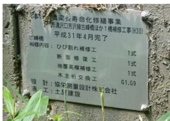
写真－13. 補修工事履歴板
