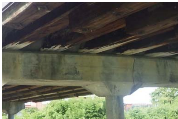
写真-8. 主桁下縁の腐朽、日覆工
