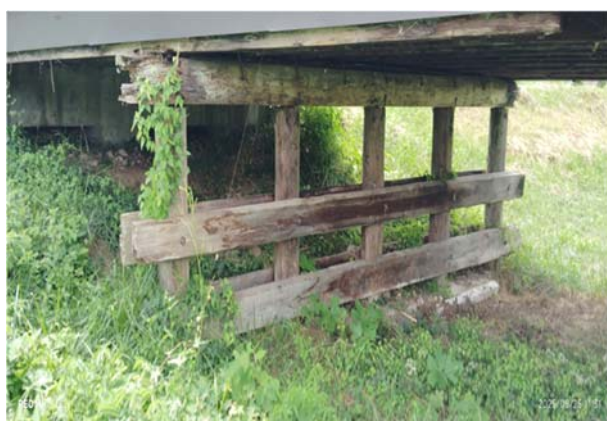
写真-5. 高水敷部に残る木製橋脚
