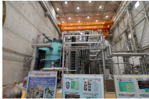
ヘリウム液化冷凍装置
