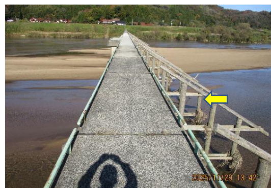
写真-13 流速抑制と流木対策の聖牛
